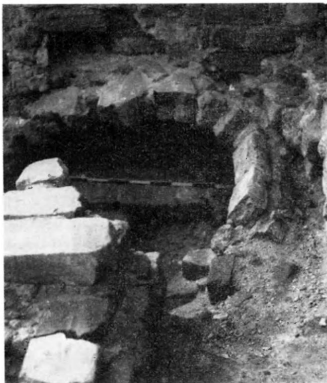
Ryc. 5. Ciechanów - Zamek. Wlot systemu ogrzewczego na terenie Domu Dużego
