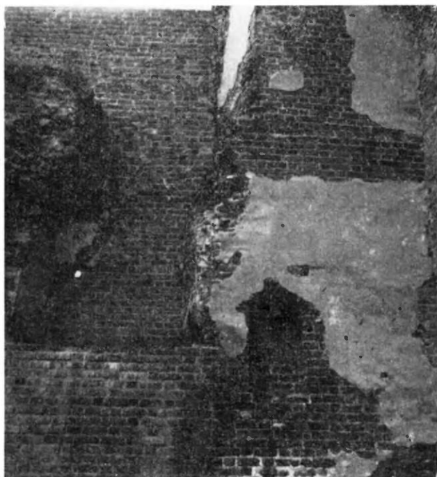
Ryc. 2. Ciechanów - Zamek. Wewnętrzna elewacja zachodniej kurtyny ze śladami zabudowy Domu Dużego
