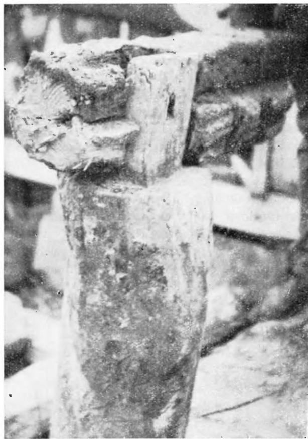
Ryc. 4. Warszawa, stanowisko Solec — budowa kolektora. Sposób łączenia poziomych i pionowych elementów konstrukcji drewnianych
