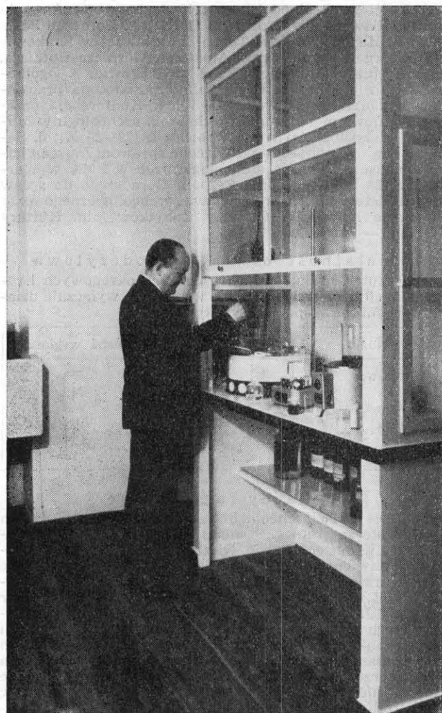
Ryc. 2. Państwowe Muzeum Archeologiczne w Warszawie. Digestorium włączone do centralnego systemu wyciągowo-nawiewnego
