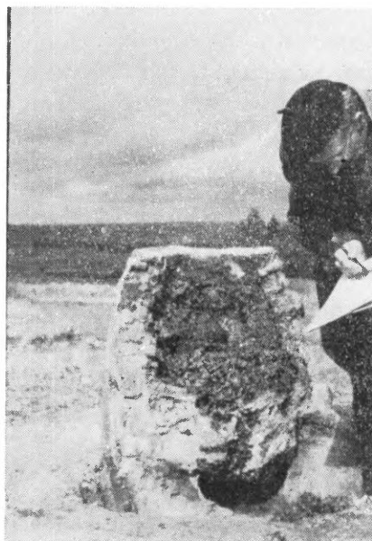
Ryc. 6. Druga seria doświadczalnych wytopów w 1962 r. Wnętrze pieca po zakończonym wytopie wypełnione żużlem i gąbką metaliczną
