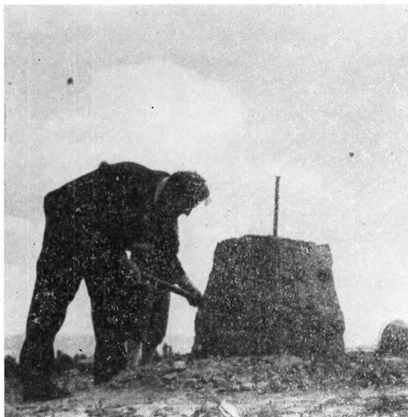
Ryc. 5. Druga seria doświadczalnych wytopów w 1962 r. Ściany szybu kotlinki uformowane nieco stożkowo
