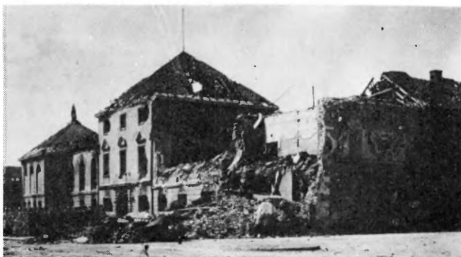
Ryc. 11. Arsenau zniszczony w czasie powstania warszawskiego. Elewacja od ul. Długiej.
