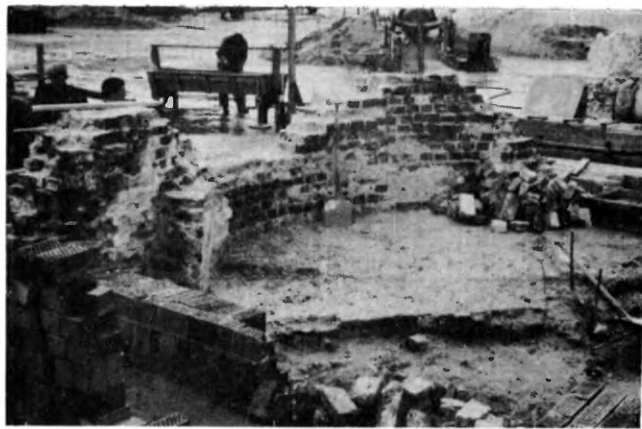
Ryc. 1. Warszawa. Zamek Królewski. Baszta Władysława IV. Widok od strony północno-zachodniej.
