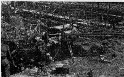
Ryc. 1. Gdańsk — Podwałe Staromiejskie. Widok ogólny na stanowisko — wykop pod „Dom Marynarza“, blok A.
